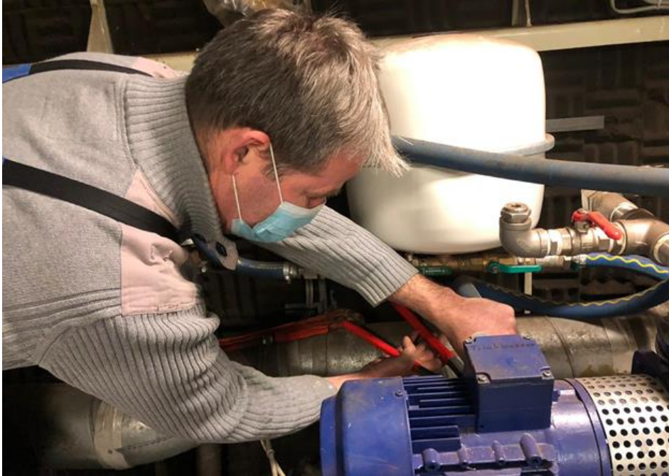
Thorsten Cummerow bei Arbeiten am Hydrophor auf MS Schaprode
